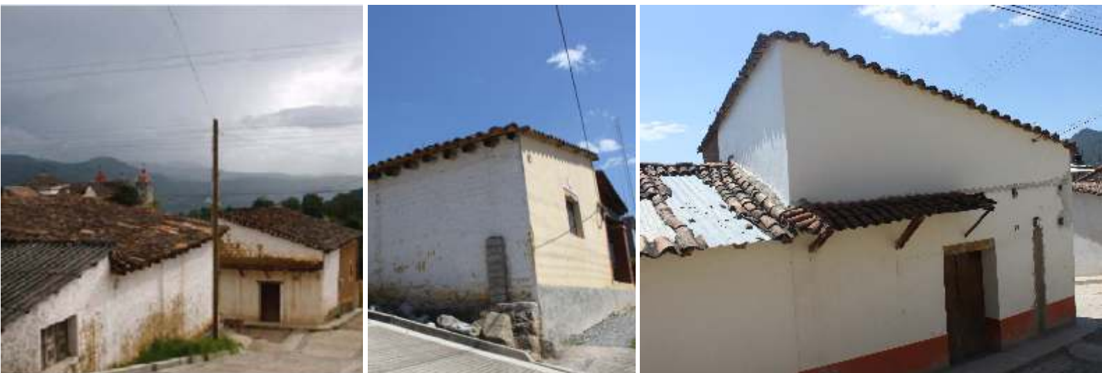
Izquierda: dos viviendas con características de tipo vernáculas. Centro y derecha: las mismas viviendas, se observa que los aplanados, colores y marquesinas fueron modificados
