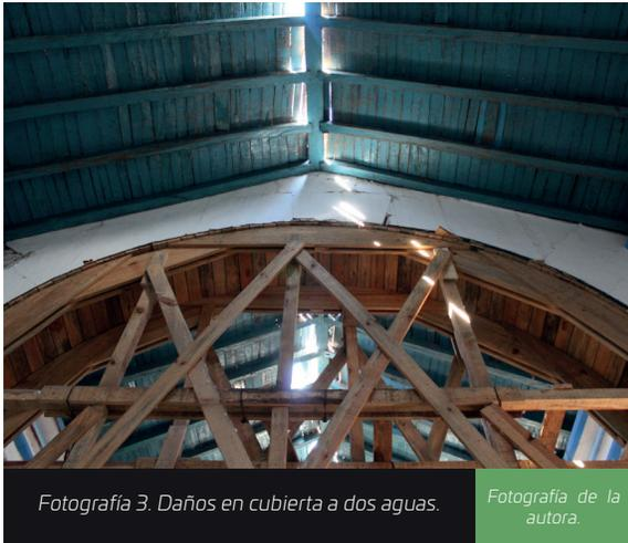
Fotografía 3. Daños en cubierta a dos aguas.
