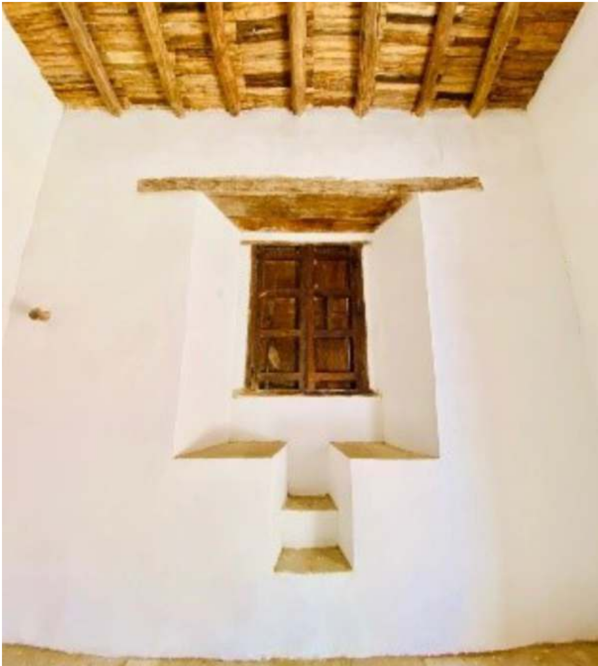
Crujía B después de intervención
