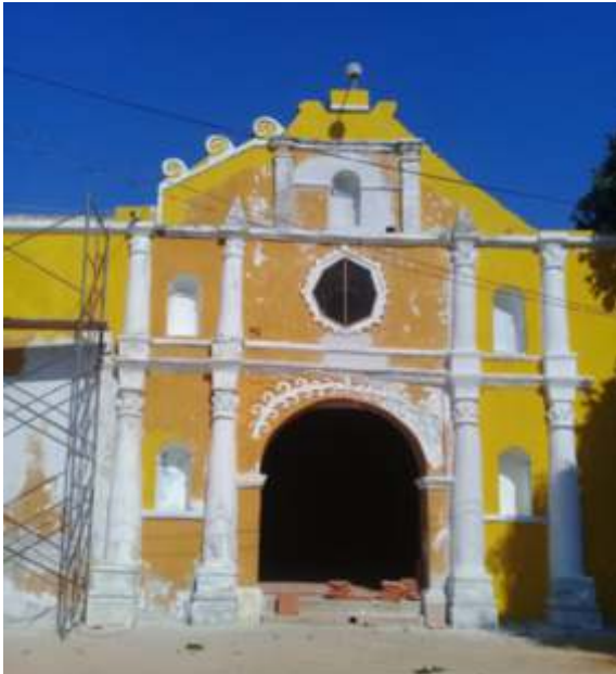
Proceso de integración de Pintura vinílica.
