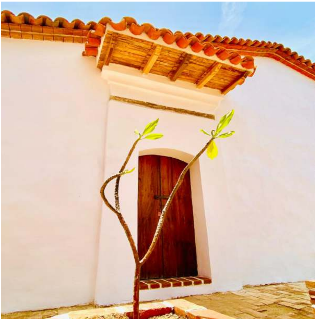
Acceso después de intervención
