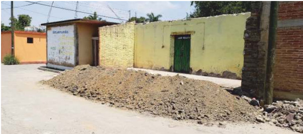
Demolición de inmueble vernáculo en Santa María del Tule
