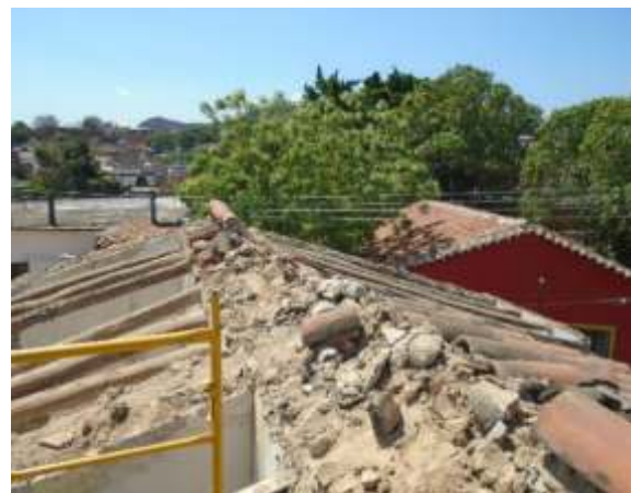
Cubierta previa a Intervención
