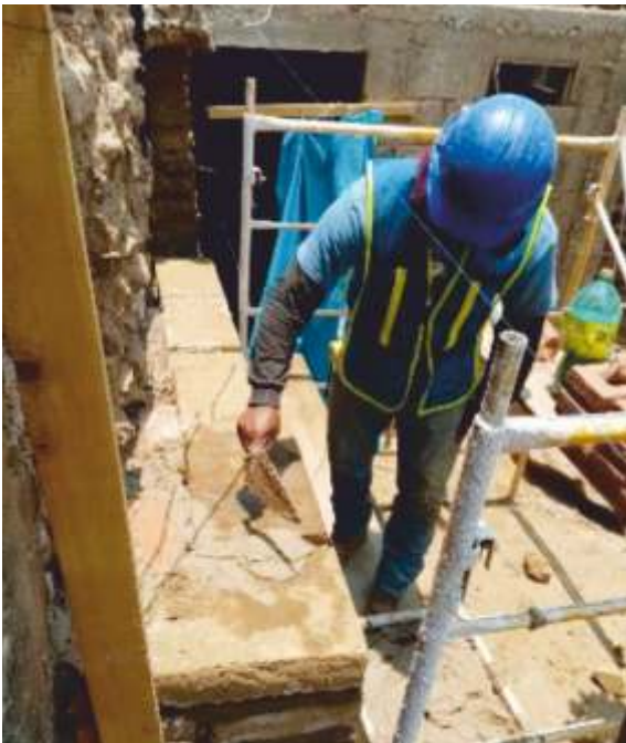
Consolidación de muro de adobe
