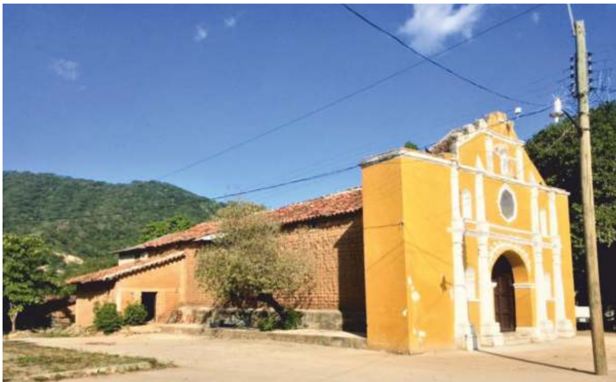
Presencia de daños en fachada principal.
