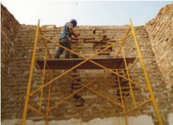
Liberación de muro de adobe
