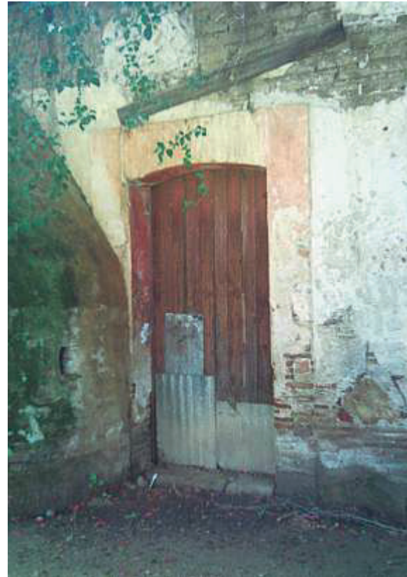
Vista del acceso a la tienda de raya.
