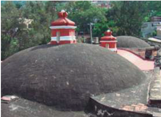
Cubierta del templo, antes de la intervención.
