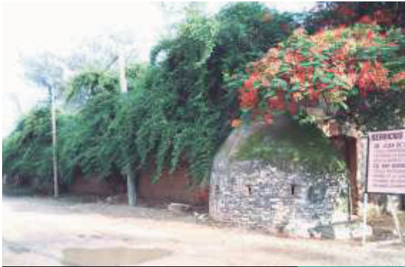
Vista exterior donde se aprecian los garitones.
