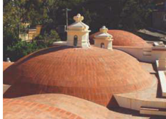
Cubierta del templo, después de la intervención.
