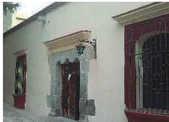
Acceso al curato después de la intervención. ARCHIVO INPAC
