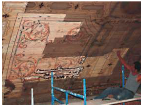
Limpieza mecánica en seco
