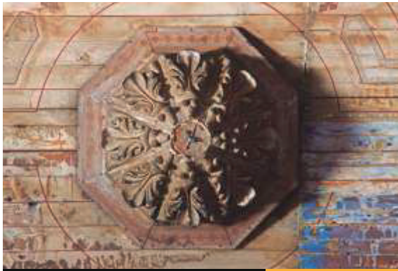
Detalle de rosetón tallado. Antes de proceso
