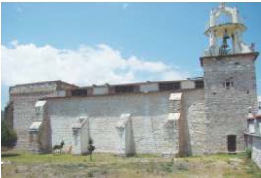
En la fachada lateral se pueden evidenciar claramente las dos etapas de construcción del edificio
