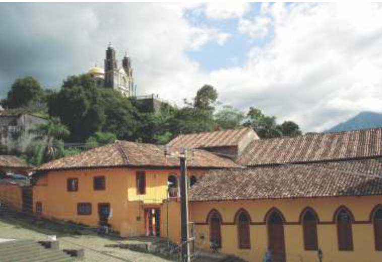
La arquitectura vernácula de Xochitlán, preserva sistemas constructivos tradicionales
