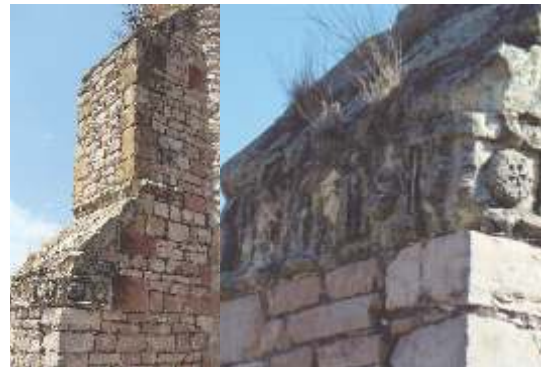
Incrustación de elementos pétreos labrados en contrafuertes
