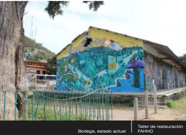
Bodega, estado actual
