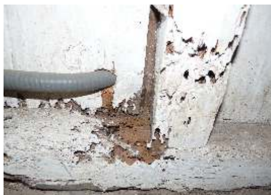
Dentro de los principales deterioros se encontraba el ataque de insectos xilofagos
