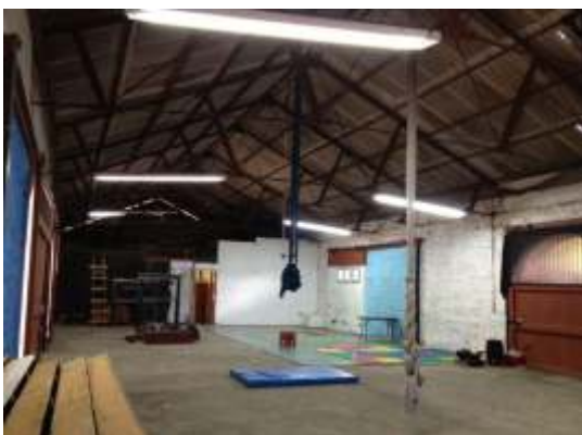
Interior de la bodega, estado actual
