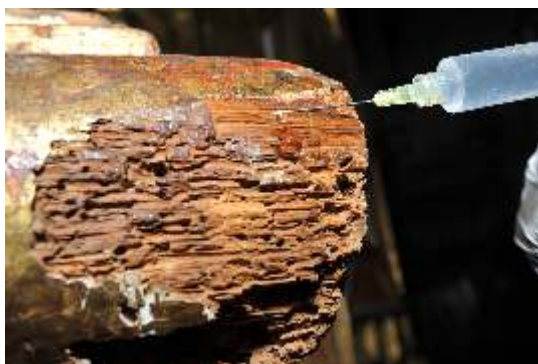
Inyecciones con líquido consolidante en áreas que presentaba ataque de insectos xilófagos
