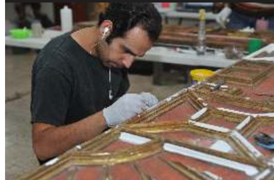
Consolidación y resane de elementos faltantes
