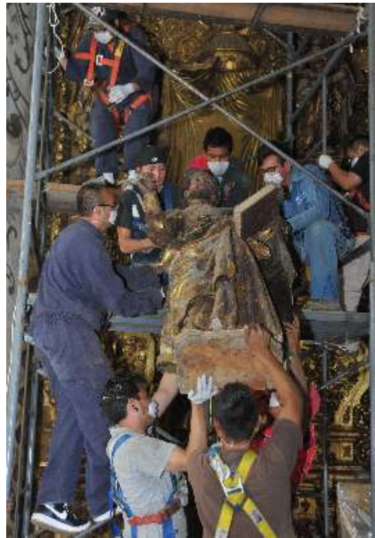
El desmontaje de elementos escultóricos se realizó con sumo cuidado
