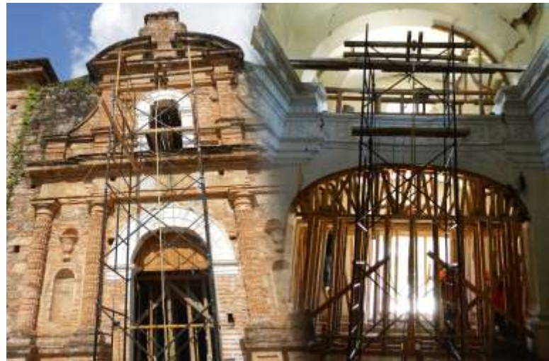
Restauración del Templo de San Antonio Tepetlapa. FOREMOBA 2011
