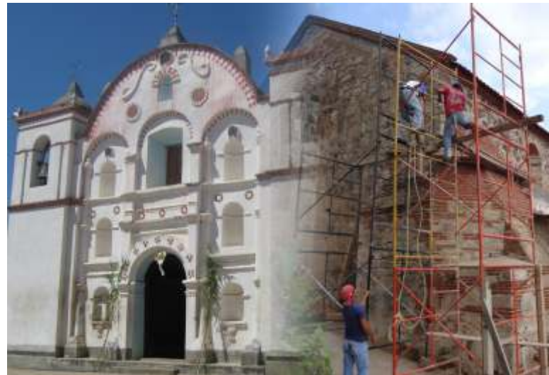
Restauración del Templo de Yatzachi el Alto. FOREMOBA 2011
