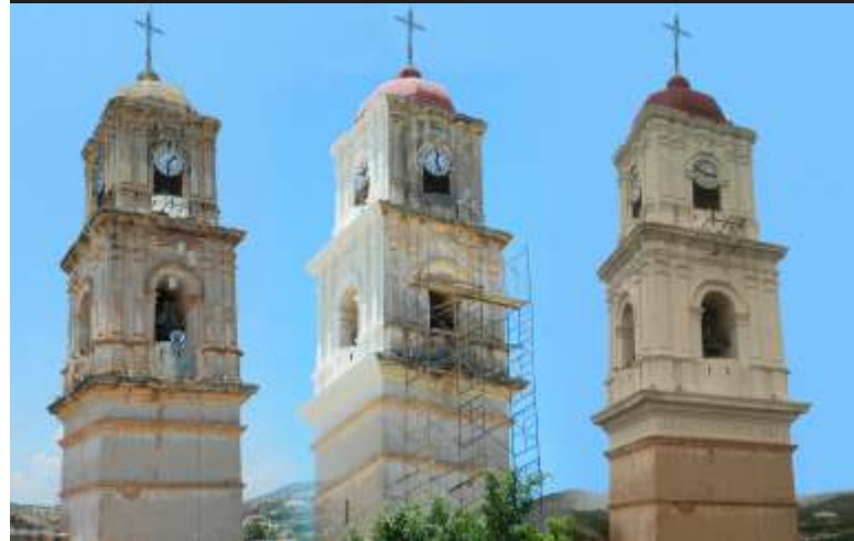
Restauración del Templo de Santiago Chazumba. FOREMOBA 2011
