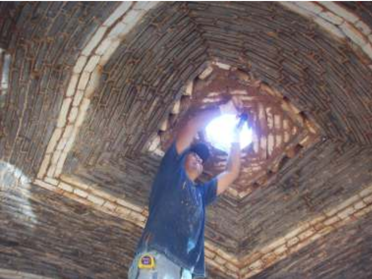
Cierre de bóveda de adobe, oficina Exaltar Construcciones, Paraguay | Fotografía Aguirre, 2011
