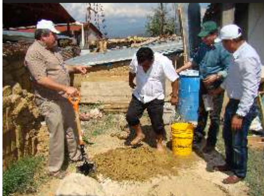
Preparación de barro para elaborar adobes
