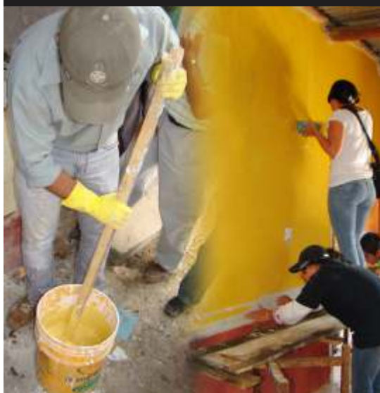
Elaboración y aplicación de pintura a la cal
