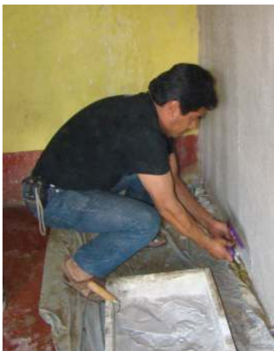
Integración de aplanados con mortero de cal
