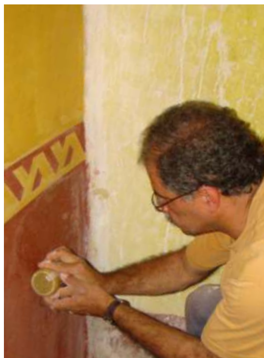
Proceso de bruñido sobre pintura a la cal
