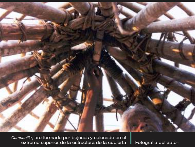
Construcción de la cubierta de un "Redondo" | Fotografía del autor
