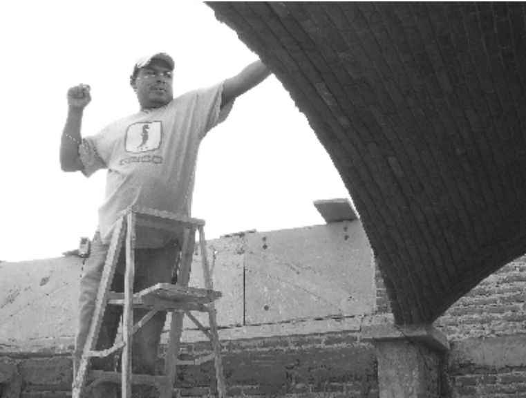
Arranque de una bóveda apoyada en una imposta, Etla, Oaxaca / Fotografía de los autores
