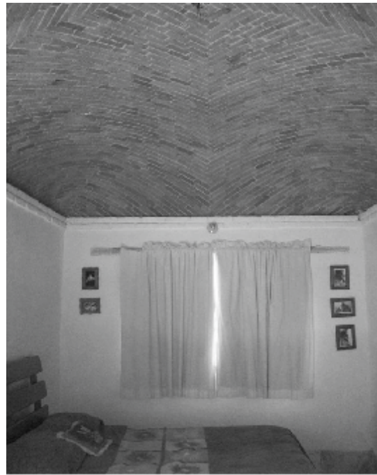
Interior de una bóveda de pechinas, Etna, Oaxaca / Fotografía del autor
