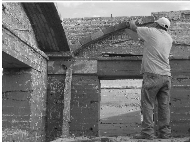
Vista de la colocación de “cuñas” / Fotografía de los autores
