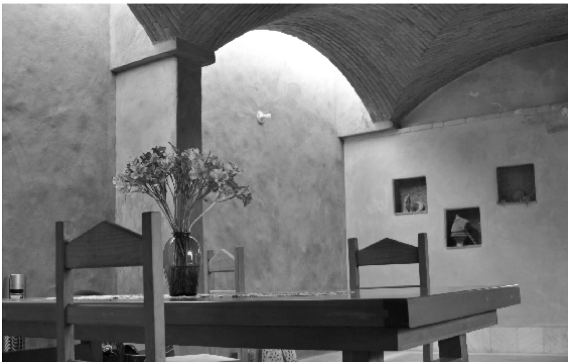
Bóvedas de arista, Soledad Etla, Oaxaca / Fotografía Alejandro Ferreiro
