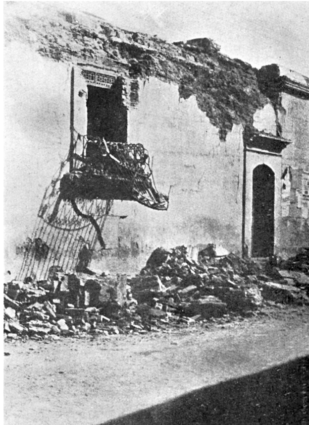
Edificio afectado por el sismo, ubicado en la esquina de las calles Aldama y Carlos M. Bustamante.
