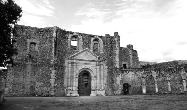
Vista parcial de la fachada poniente del ex convento de Cuilapan. De derecha a izquierda, muro del baptisterio, portada del antiguo templo tras los trabajos de intervención y portal de peregrinos./ Fuente: Fotografía Itzel Alarcón Sánchez.
