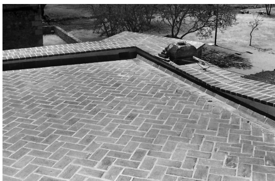
Aspecto final de la cubierta de la capilla del Santísimo del templo de una nave de Cuilapan, una vez concluida la intervención./ Fuente: Archivo INPAC.
