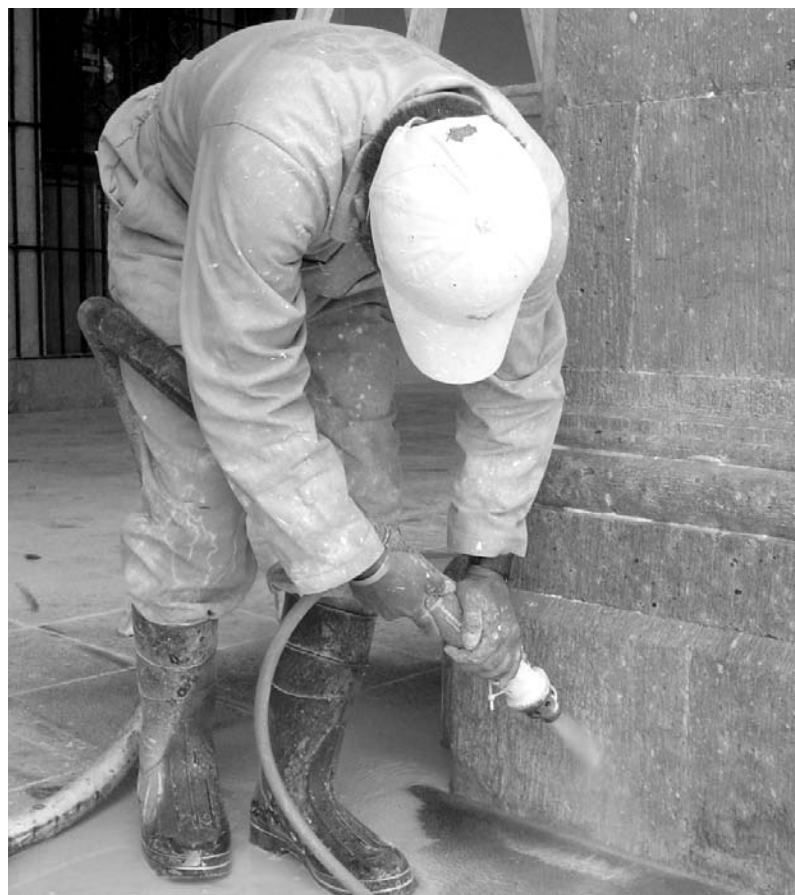
Limpieza con carbonato de calcio a presión controlada en base de pilastra del Museo del Palacio / INPAC 2006
