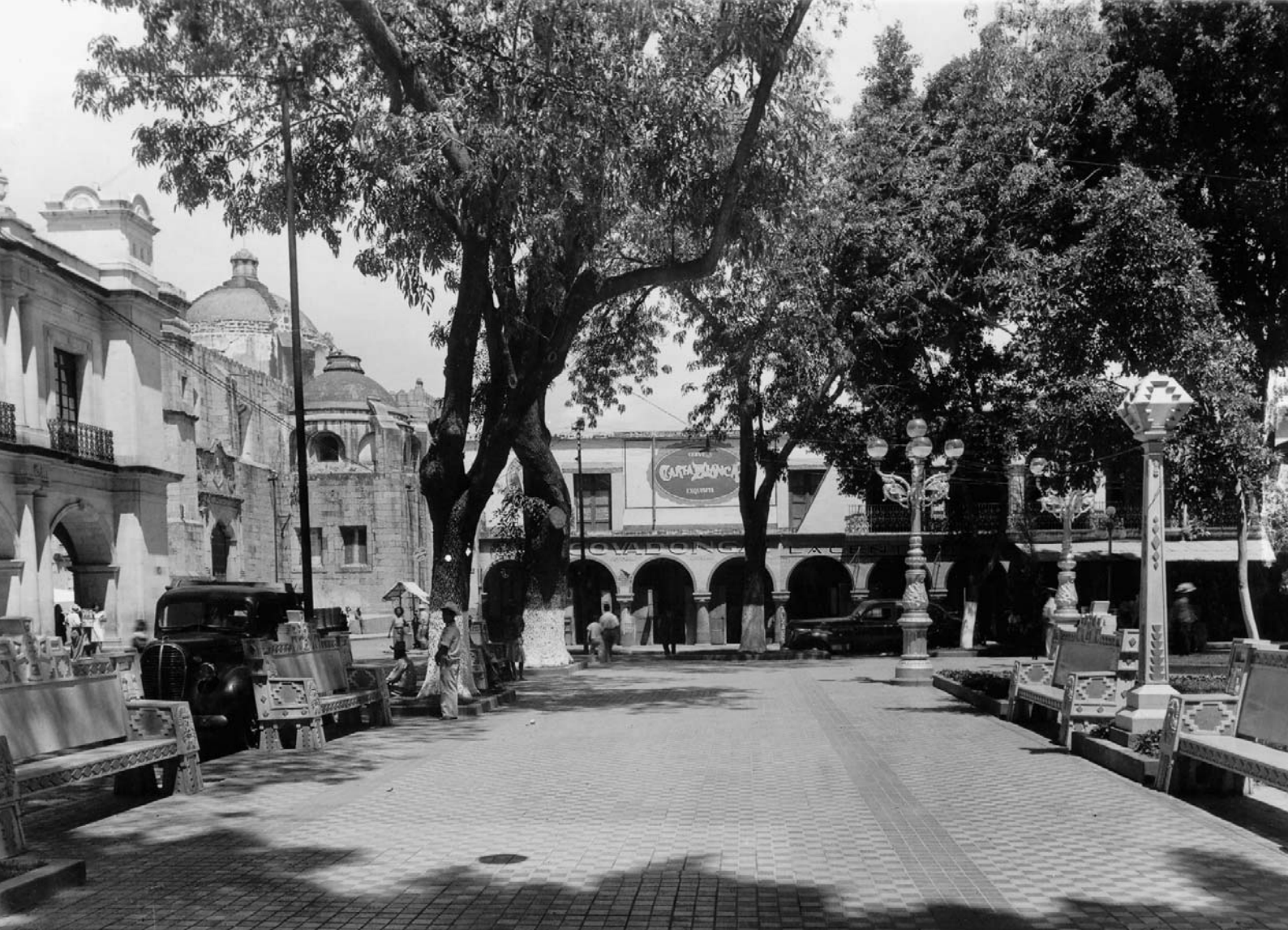
Imagen que ofrecía el Zócalo y los Portales antes de la intervención de 1972 / Fundación Cultural "Bustamante-Vasconcelos" A.C.
