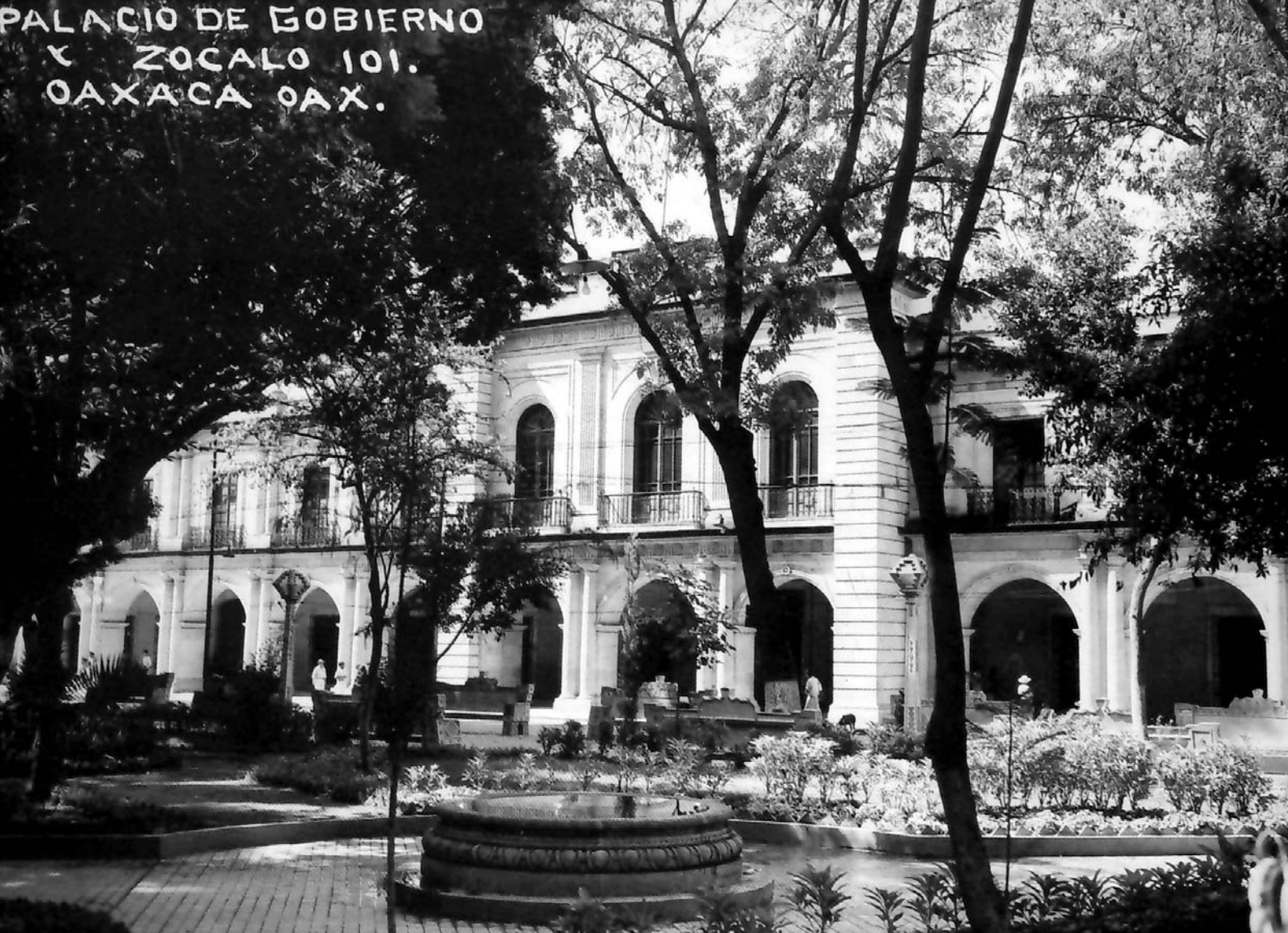
Imagen que lucía el Zócalo de la Ciudad de Oaxaca antes de la intervención de 1972 / Fundación Cultural "Bustamante-Vasconcelos" A.C.
