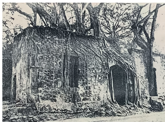
Figura 3. Fachada principal del inmueble tomada en 1977. | Archivo de CNMH
