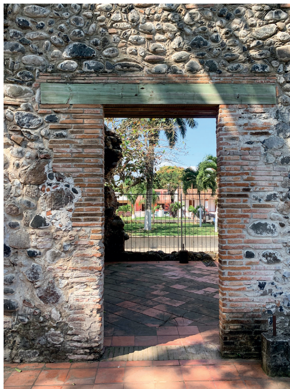
Figura 6. Interior después de la intervención realizada en 2010 | Karen Rodríguez
