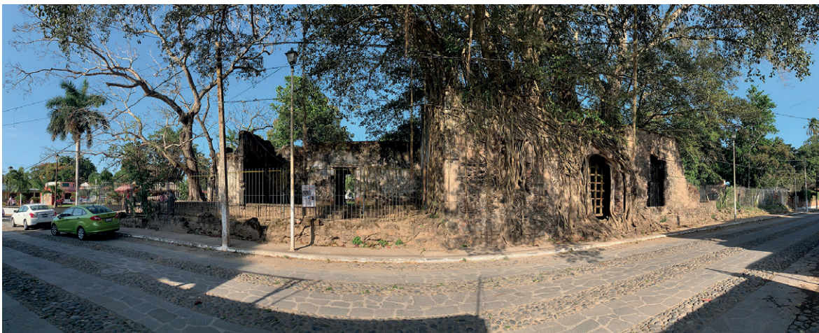
Figura 7. Fachada principal de "La Casa de Cortés", donde se observa el estado de sus muros y la relación con la vegetación, así como herrería que se ha agregado para su protección. | Karen Rodríguez, 2023.
