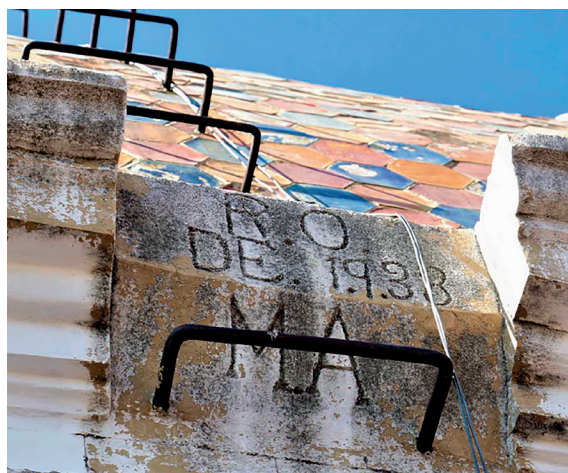
Figura 6. Grabado en cúpula de concreto armado | Javier Jarquín
