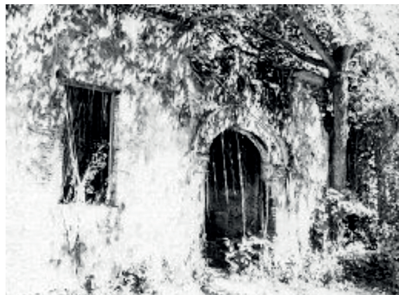
Figura 2. Fachada principal del inmueble tomada en 1951. | Archivo de CNMH
