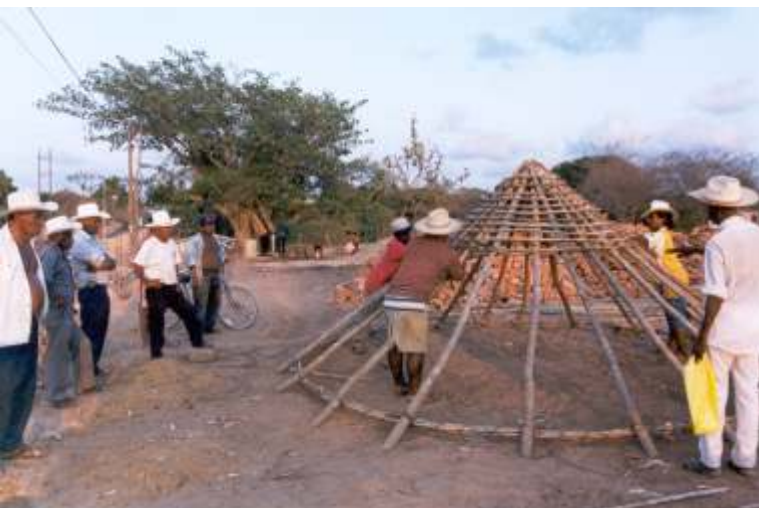
Construcción de la cubierta de un "Redondo" | Fotografía del autor
