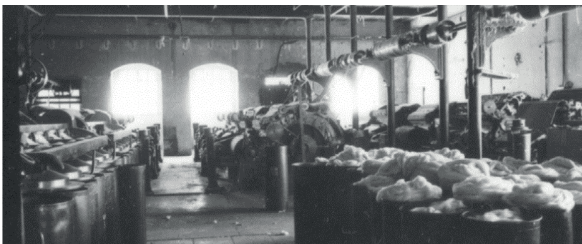
Foto 2 // Vista de la sala de maquinas de la fábrica
