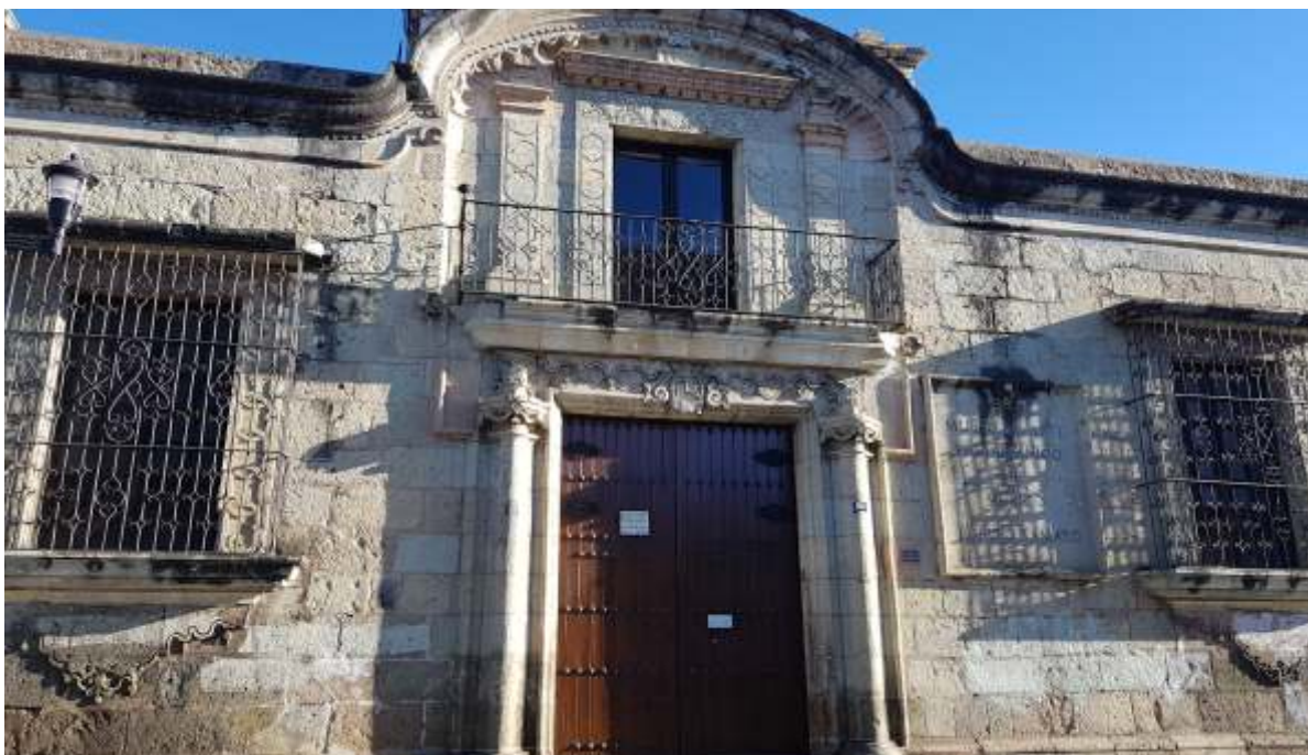
Fachada. En la imagen podemos observar el entrepiso sobre el zaguán con su remate en arco, elementos llamativos y distintivos del edificio.
