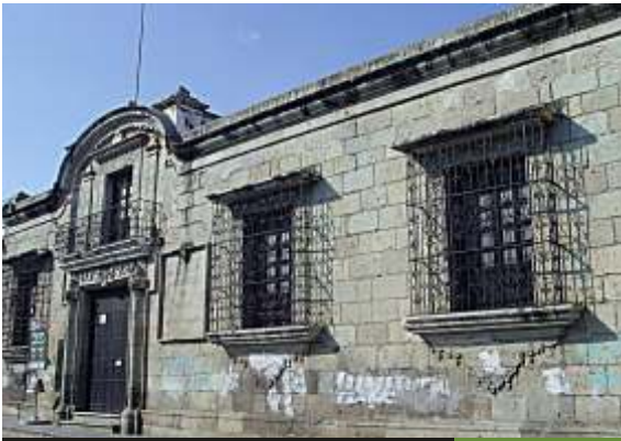
Fachada. Por la ausencia actual de los enclavados, podemos apreciar su sistema constructivo a través de los sillares y la cantera como material constructivo principal.
