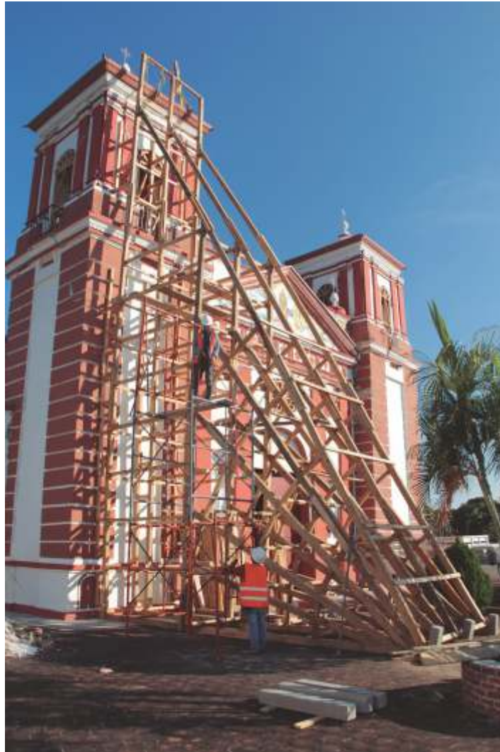
APUNTALAMIENTO DE TORRE Y CAMPANARIO DEL TEMPLO DE SANTO DOMINGO DE GUZMÁN, SANTO DOMINGO CHIHUITÁN
