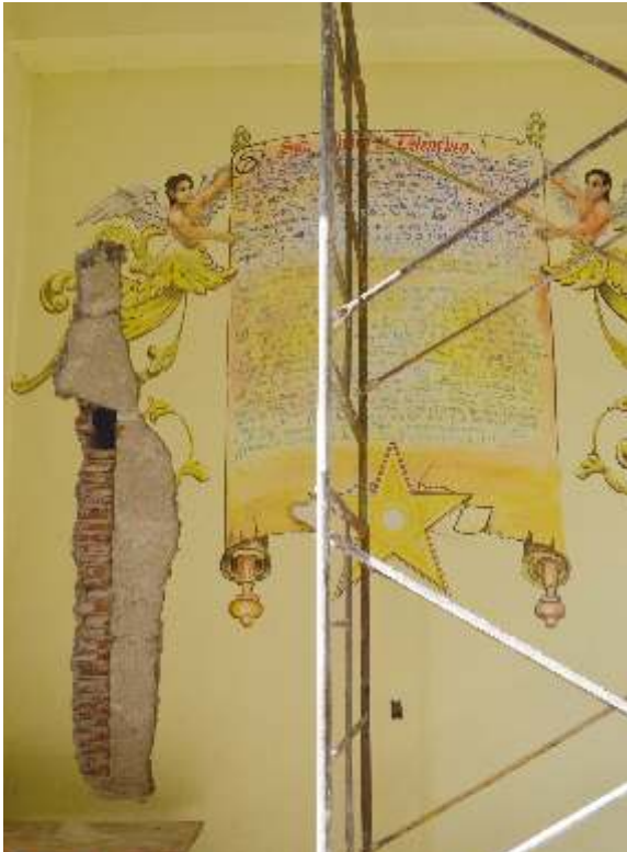
Cala arquitectónica en el muro.
