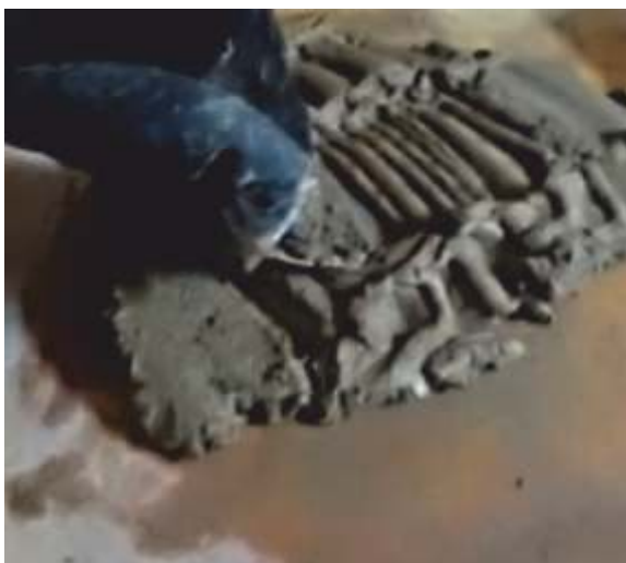
Mezcla del Mortero
