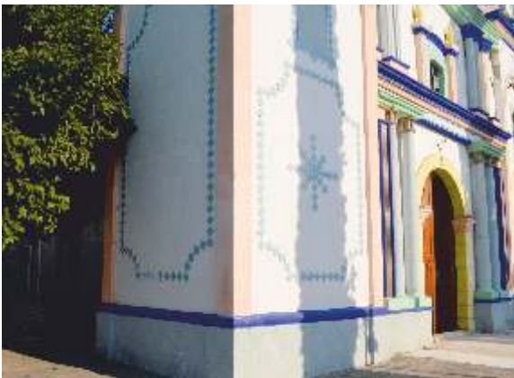
Primera visita de inspección al templo de San Nicolás Tolentino.
