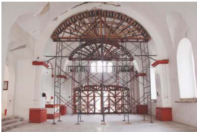
APUNTALAMIENTO DE ARCOS FAJONES EN EL TEMPLO DE LA PARROQUIA DE SAN JERÓNIMO DR. CD IXTEPEC.
