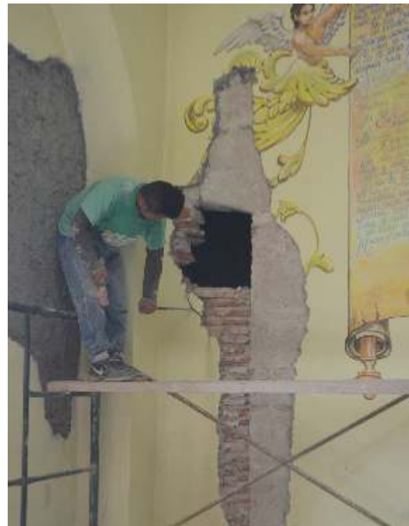
Apertura de agujero en muro para poder ingresar
