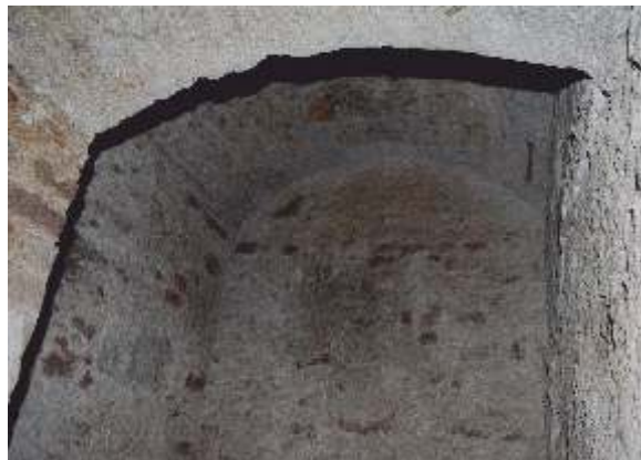
Primera visita de inspección al templo de San Nicolás Tolentino.
