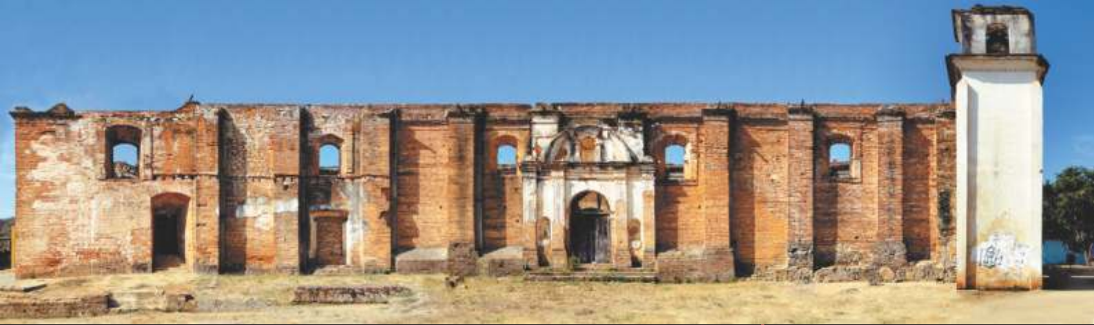
Larguillo fachada norte del templo, estado anterior a la intervención
