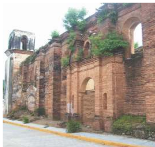
Estado actual de la fachada sur
