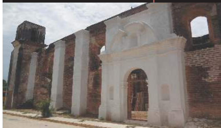
Integración de aplanados en contrafuertes y en portadas
