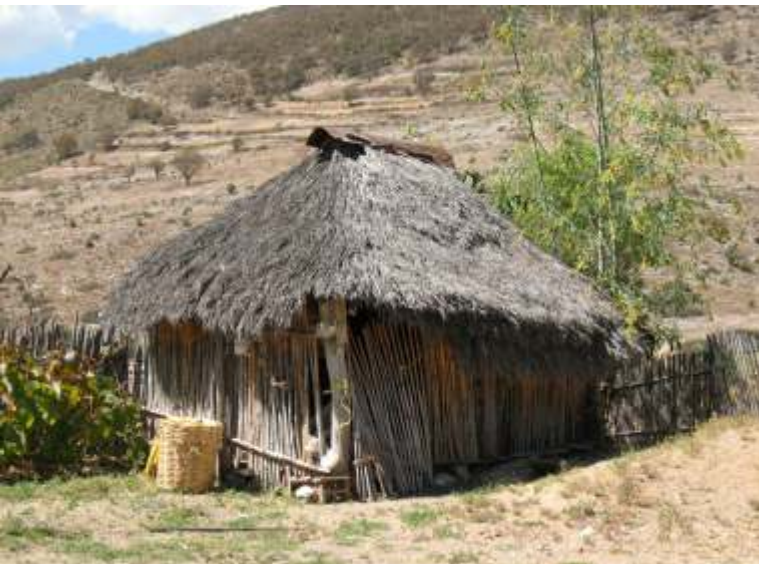
Casa de materiales vegetales Ihuatlán Plumas, Oaxaca | Fotografía del autor
