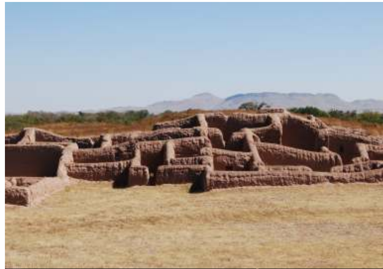
Aunque en diversos textos se dice que la ciudad de Paquimé, en Chihuahua se construyó con la técnica de tapial, los patrones de deterioro de sus restos evidencian que se edificó con barro vertido
