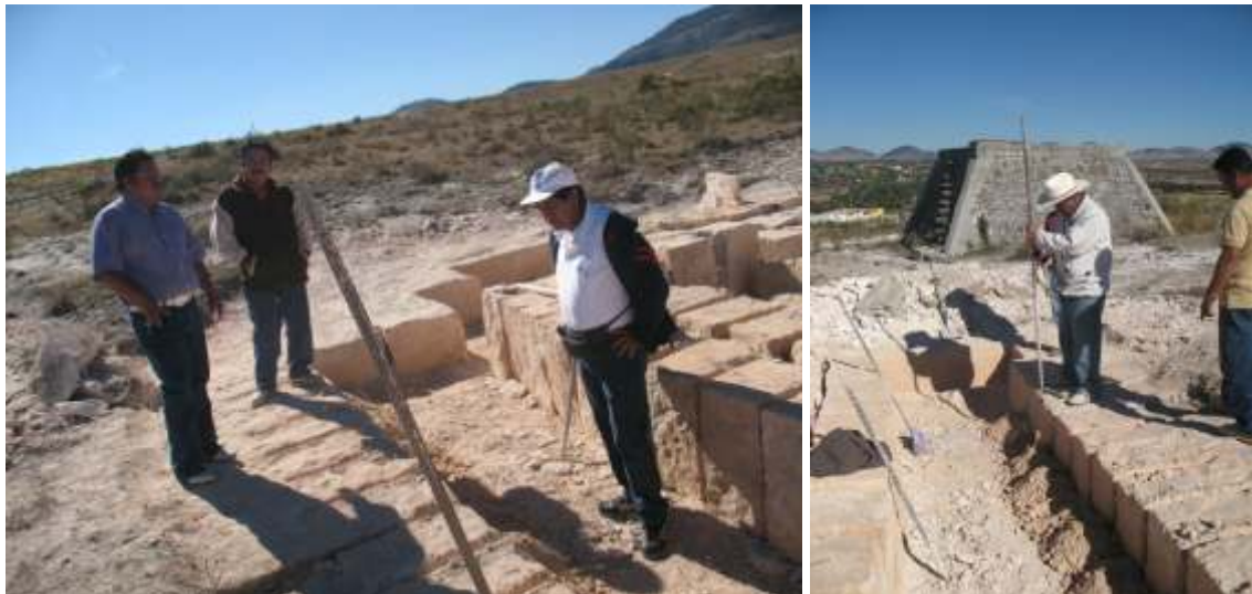
Obtención de los bloques de tierra, de manera tradicional
