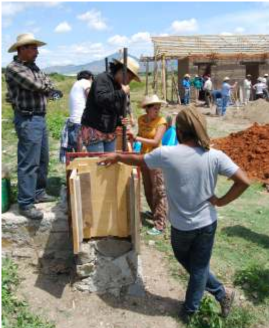
Inicio de un muro de tapia en un taller comunitario realizado en 2011 en San Pedro Apóstol, Ocotlán, Oaxaca
