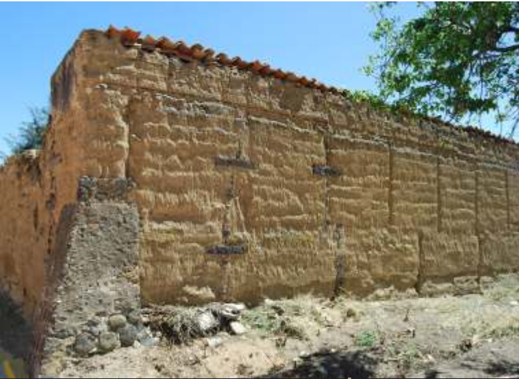
Vivienda de tapial en Calpan, Puebla
