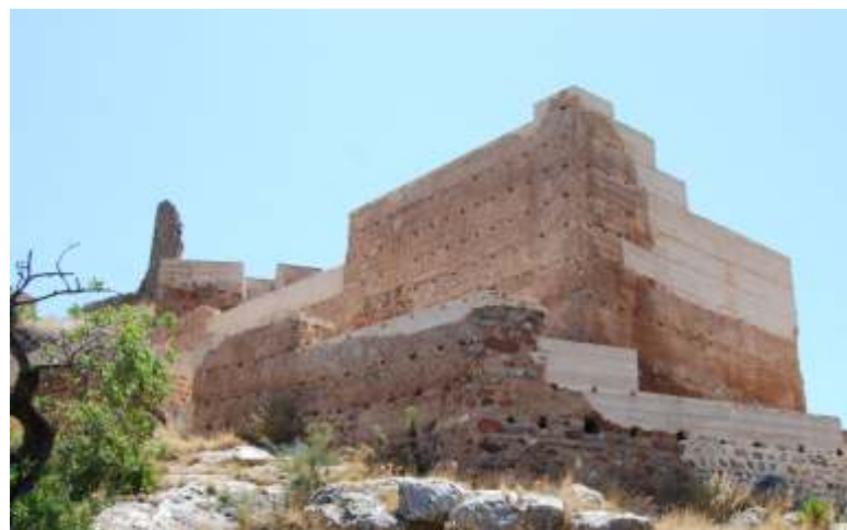
El patrimonio construido con tapial y que ha resistido más de mil años es la mejor fuente de aprendizaje de la edificación tradicional. Castillo medieval de Desert de Les Palmes, Valencia
