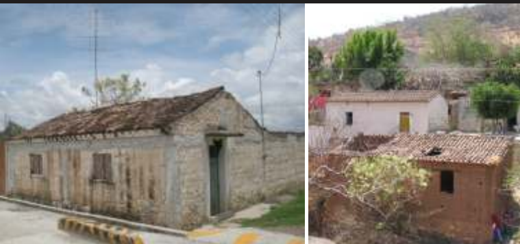
Viviendas tradicionales alteradas con concreto armado. Ihuatlán Plumas y Guadalupe de Ramírez, Silacayoapam, Oaxaca | Fotografías del autor
