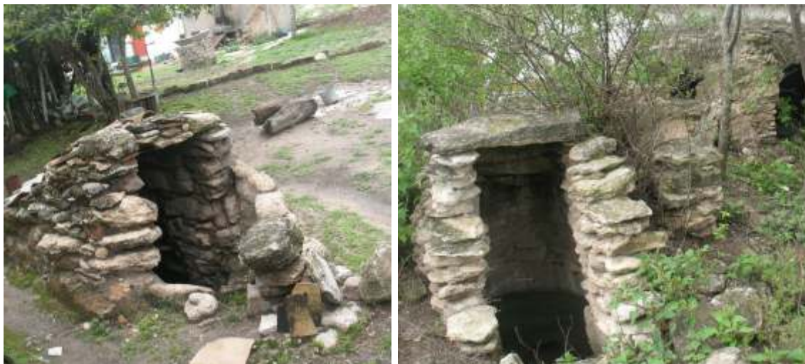
La cueva, construida con piedras de tierra compactada de manera natural | Fotografías del autor
