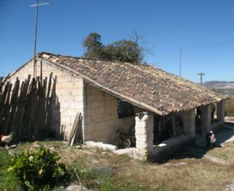
Casa de bloques de tierra con corredor. Tlapiltepec, Oaxaca | Fotografía del autor
