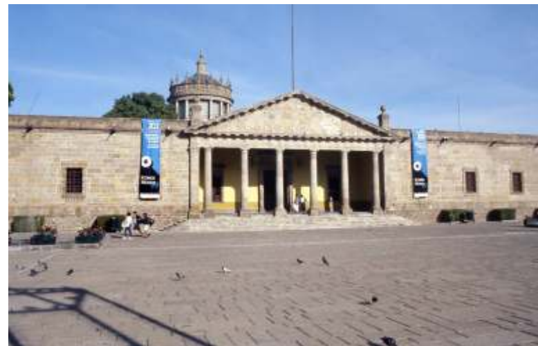
Hospicio Cabañas, Guadalajara. Elementos Neoclásicos en su edificación
