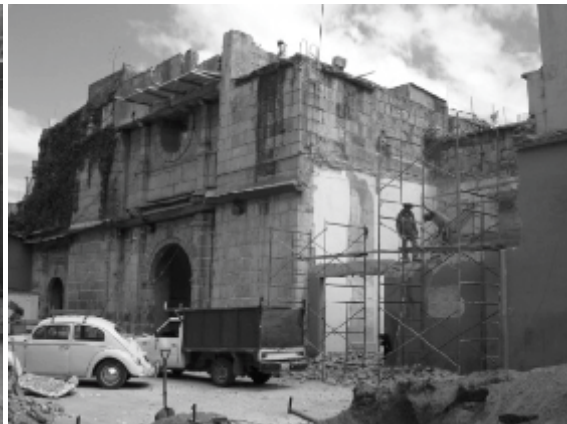
Liberación de muro agregado frente a la Capilla del Rosario/Fotografía del autor
