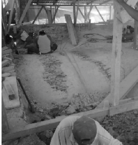
En la cubierta de la capilla del Rosario, se realizó la consolidación de la bóveda que presentaba fracturas por sismo, Sep. 2009 / Fotografía del autor
