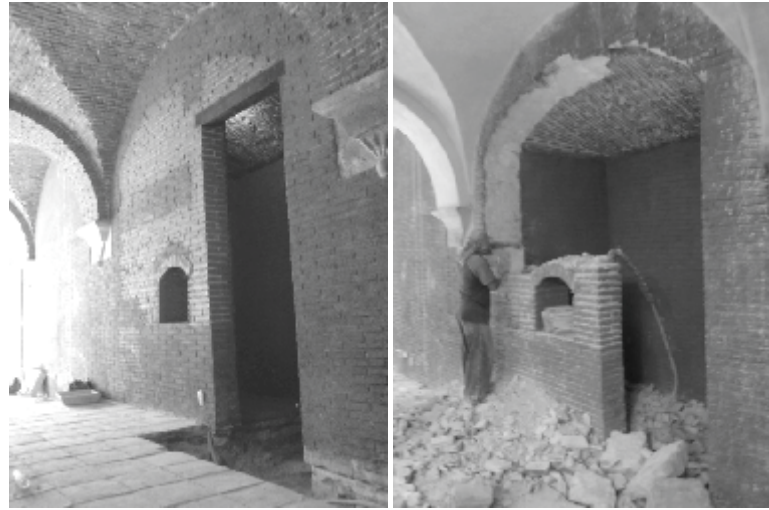
Liberación de arcos tapiados para recuperar el vestigio original de acceso al templo / Fotografía del autor
