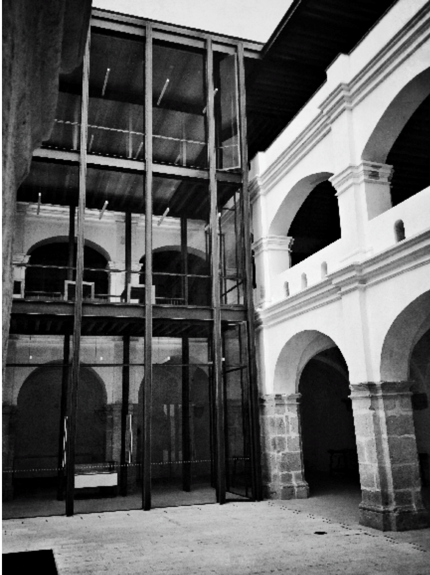
Patio principal del claustro, inserción de arquitectura contemporánea/ Arq. Hertzain Vásquez Hernández - FAHHO
