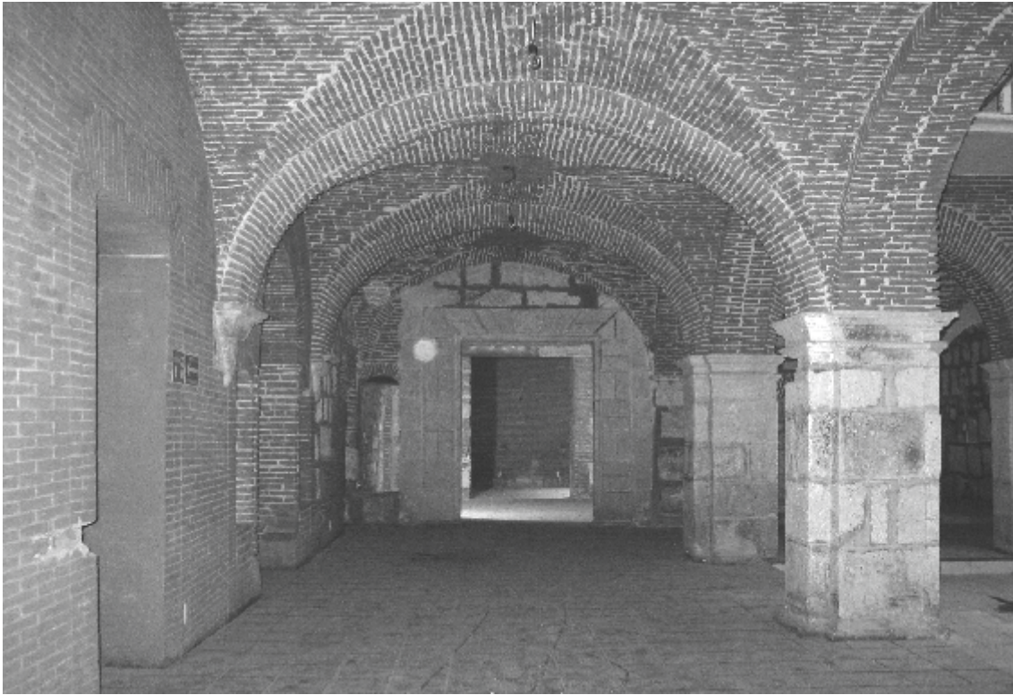
Bóvedas de arista de tabique rojo ubicadas en corredores de planta baja del Claustro / Fotografía del autor
