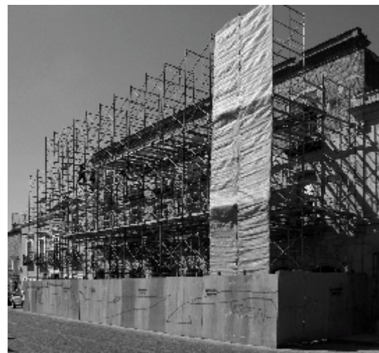
Intervención de la fachada del siglo XIX sobre la calle de Fiallo / Fotografía del autor
