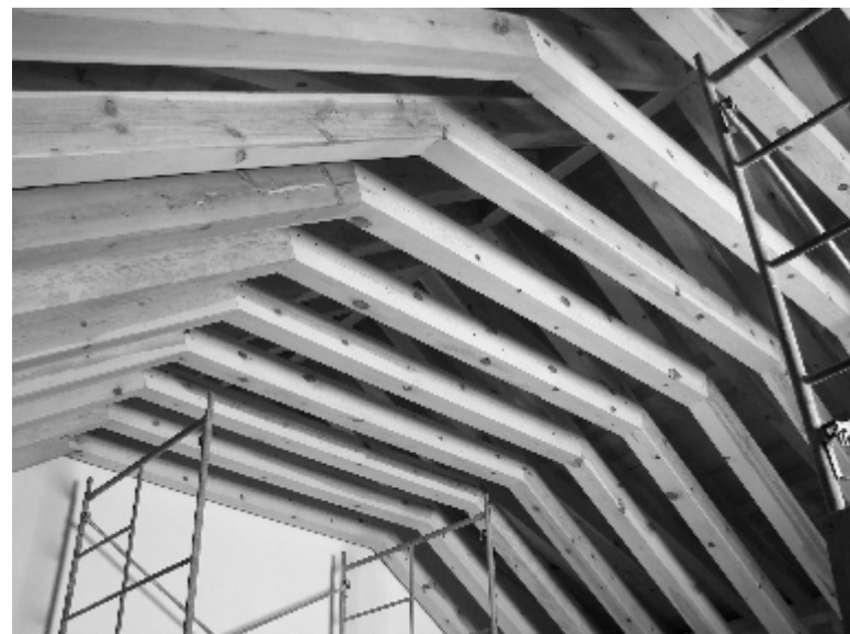
Viguería de madera conformada por armadura de par y nudillo en el coro del templo / Fotografía del autor
