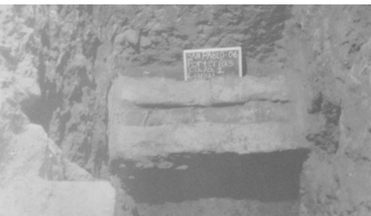
Portería. Cala 1. Canal de agua / Fotografía Gilberto H. D.
