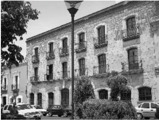
Fachada de finales del siglo XIX sobre la calle de Fiallo, antes de la intervención / Fotografía del autor
