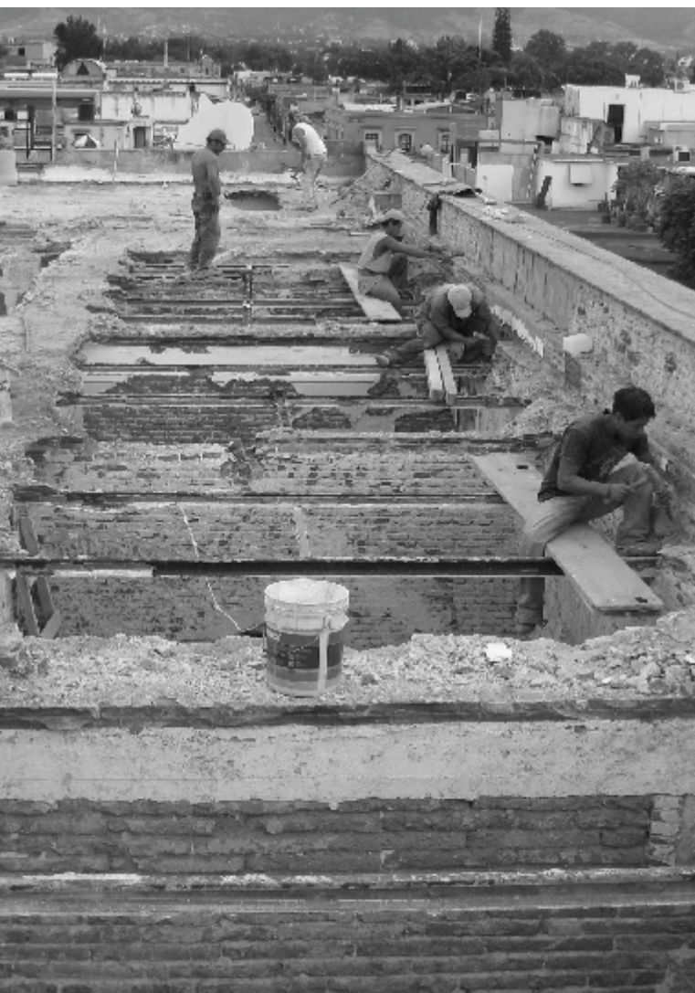
Cubierta a base de bóveda catalana de tabique sobre vigería metálica tipo I/ Fotografía del autor
