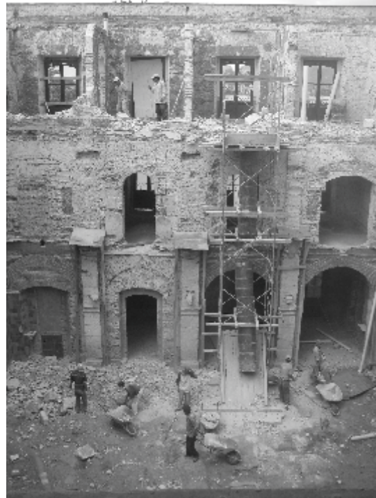
Anexos construidos en la etapa que fungía como vecindad / Fotografía del autor
