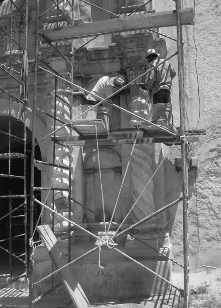
Procesos de trabajos de restauración en la fachada principal del templo de San Bartolo Soyaltepec / archivo INPAC
