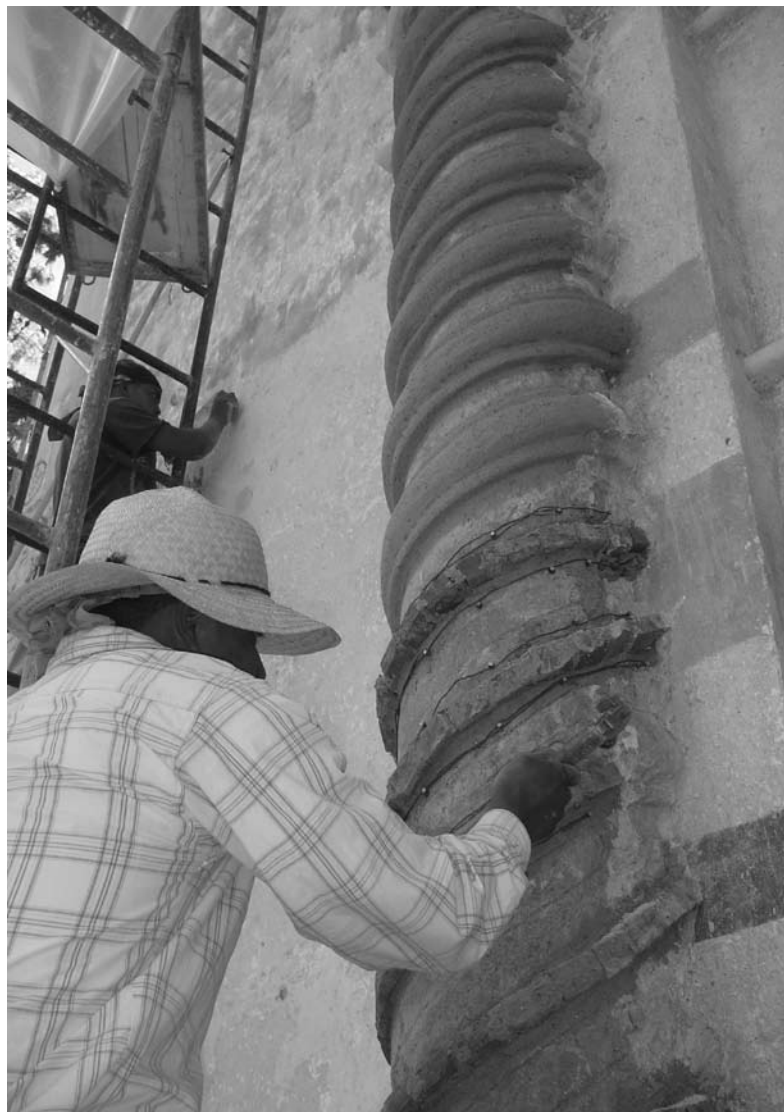
Proceso de trabajos en la fachada del templo de San Bartolo Soyaltepec / INPAC
