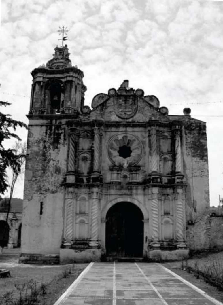
Portada principal de templo de San Bartolo Soyaltepec. Estado de conservación previo a su intervención / archivo INPAC
