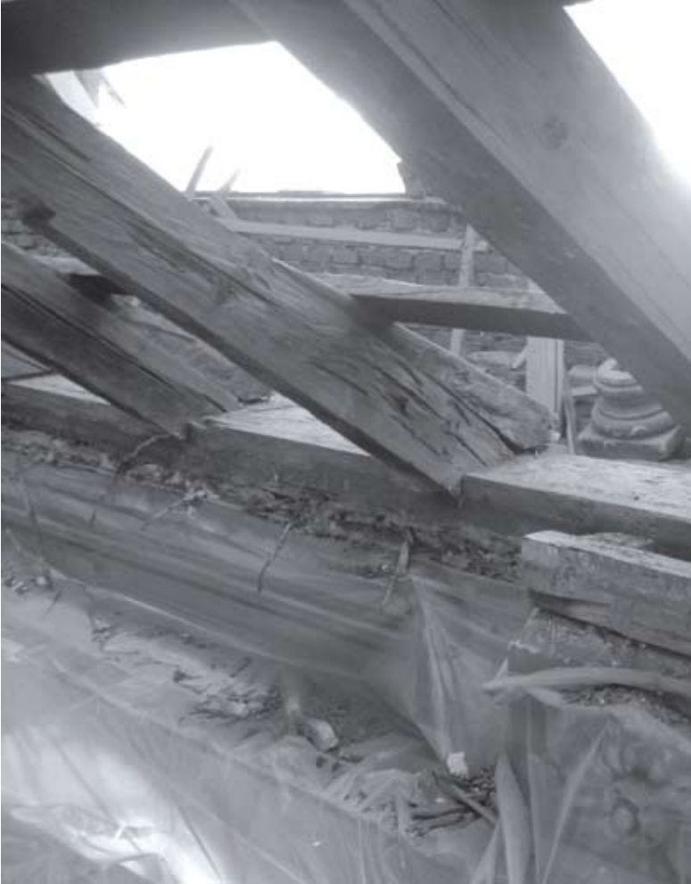
Estado de conservación de la estructura de la cubierta, previo a su intervención / archivo INPAC
