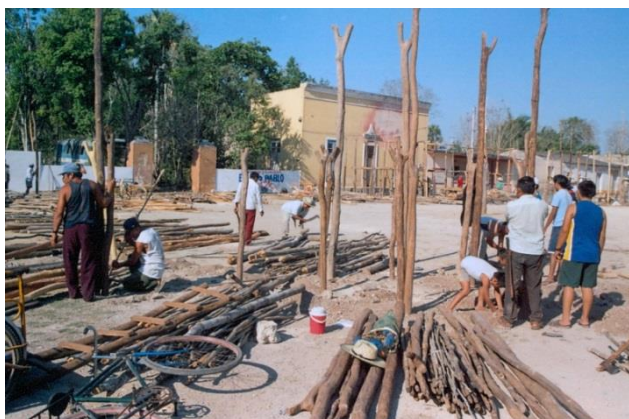
Figura 6: Construcción de los tablados con los mismos materiales utilizados en la casa maya, Nunkiní, Campeche. Fuente: Sánchez, 2000
