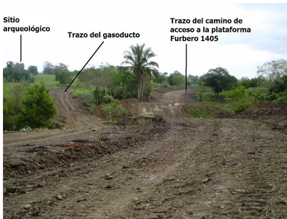
Figura 1. Extensión de trazo del camino de acceso a plataforma petrolera y gasoducto. Fuente: María Eugenia Maldonado Vite
