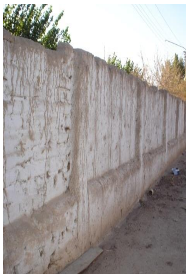
Figura. 1: Muro de adobe, Departamento Iglesia. Fuente: Ana Valeria Pochi y Juan Arturo Pereyra
