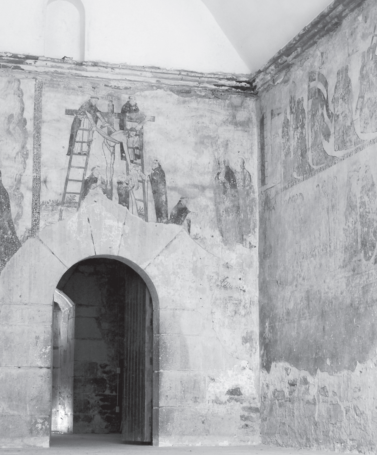
Pintura mural del S. XVII sobre los aplanados de cal de los muros de la portería del Ex Convento de San Juan Teitipac, Oaxaca.
