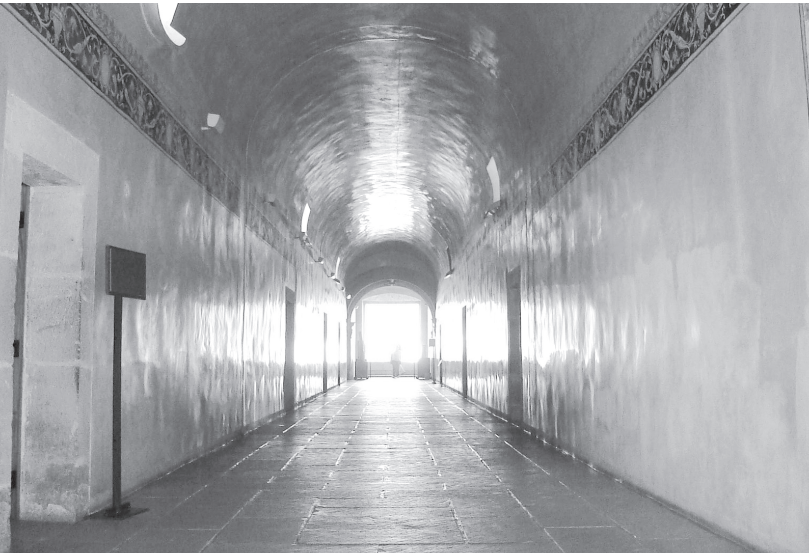
Aplanados de cal bruñida. Ex Convento de Santo Domingo, Oaxaca.
