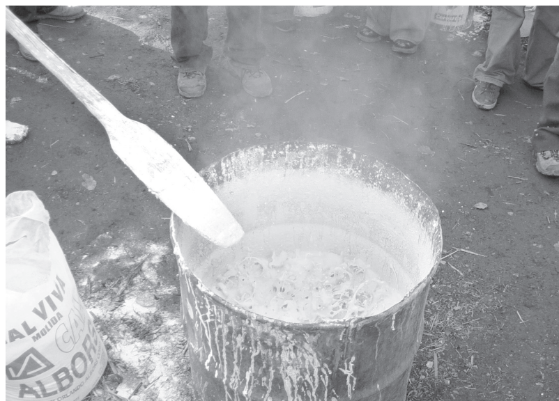
Apagado de cal
