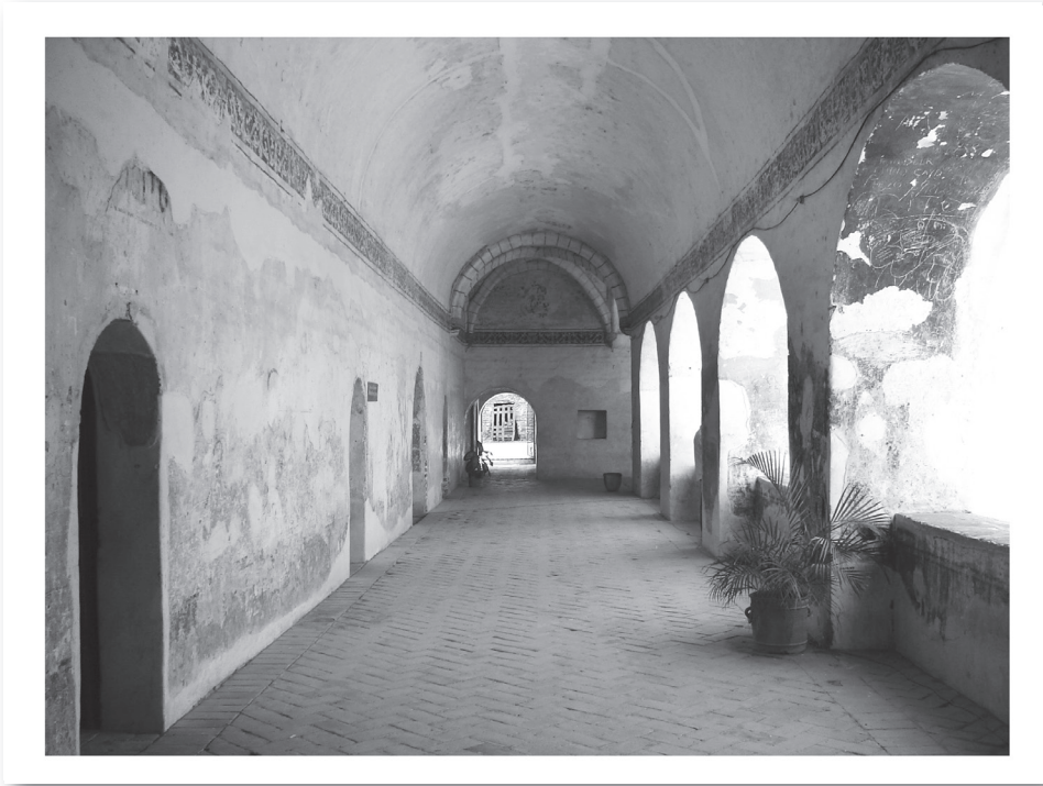
CLAUSTRO BAJO DEL EX CONVENTO DE SANTO DOMINGO Santo Domingo Tehuantepec, Oaxaca. Fotografía: Archivo INPAC
