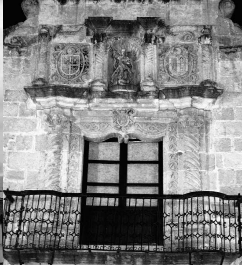
Segundo Cuerpo de la portada principal del MACO, antes de su intervención / INPAC
