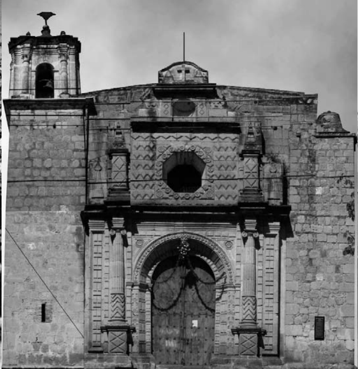
Fachada principal de San Matías Jalatlaco antes de su intervención / INPAC
