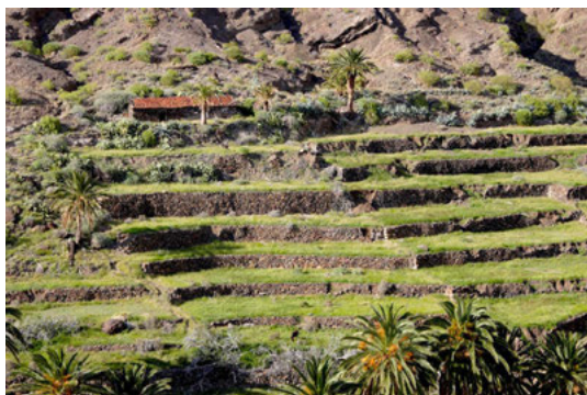
Fig. 3 Paredones y vivienda. La Gomera
